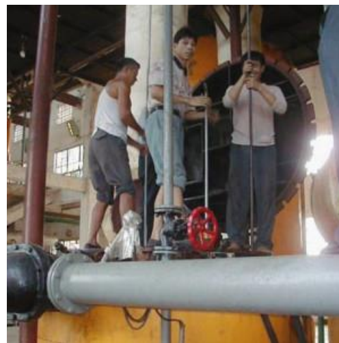
Очистка производится при помощи длинных стальных щеток
