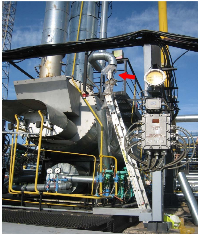
Гидрофлоу С-60 Ех защищает от накипи колонну регенерации метанола (Газпром). Фото в момент монтажа. Модель во взрывозащищенном исполнении.
