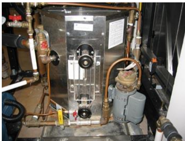
медицинский парогенератор оснащен системой водоподготовки Гидрофлоу
