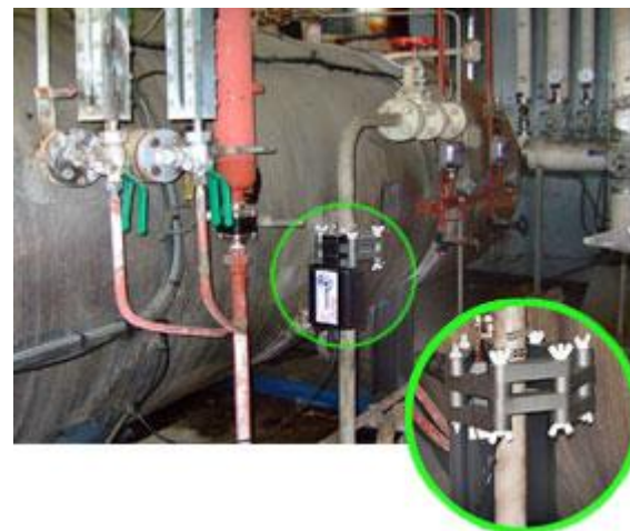
Гидрофлоу серии S на паровом котле 1500 кг/час
