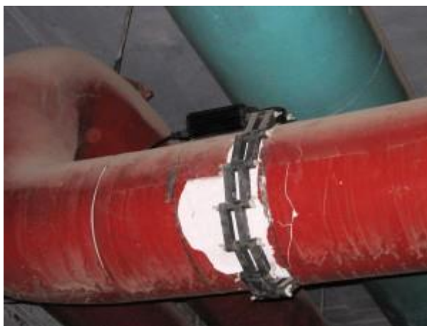
Гидрофлоу Custom C-14 защищает от накипи водогрейные котлы ЦТП
