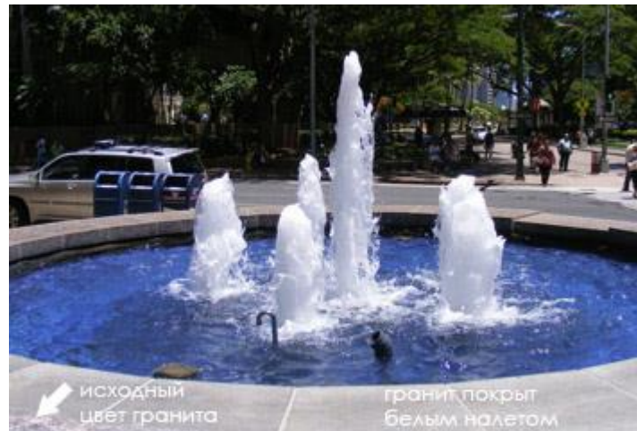
Налет известковых отложений и хим. реагентов покрывал гранит слоем белого цвета
