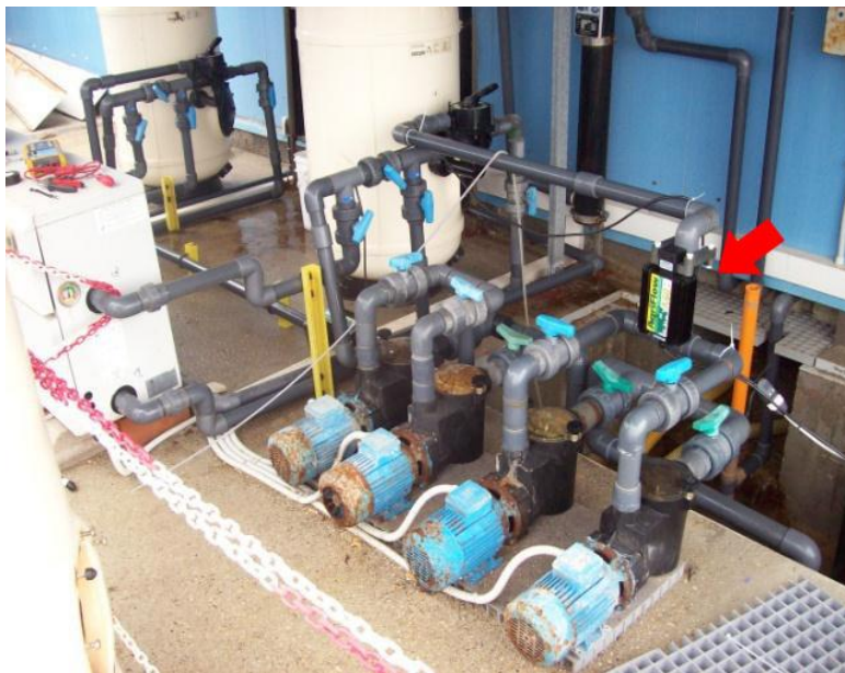
Насосный узел инкубаторной станции, с установленными устройствами Агрифлоу А-60
